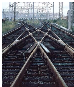
マンガン鋼製特殊軌条 鉄道レール分岐部に利用 (大同特殊鋼)
